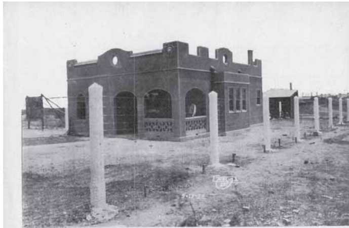
Una de las casas que formarán en Monterrey, N. L., la Colonia de los empleados y obreros de la Cervecería Cuauhtémoc. Estas casas son construídas en su totalidad con productos de concreto manufacturados por los Hrs. Muguerza Hnos. S. de C.
