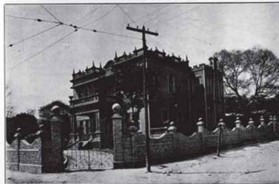
Residencia de D. Antonio Muguerza en Monterrey. Ja de concreto.
