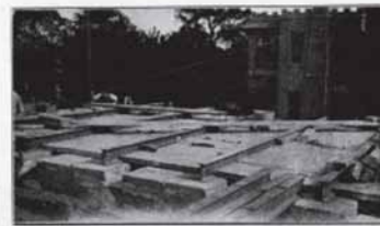
Losas de concreto de «La Victoria» en una construcción regionmontana.
