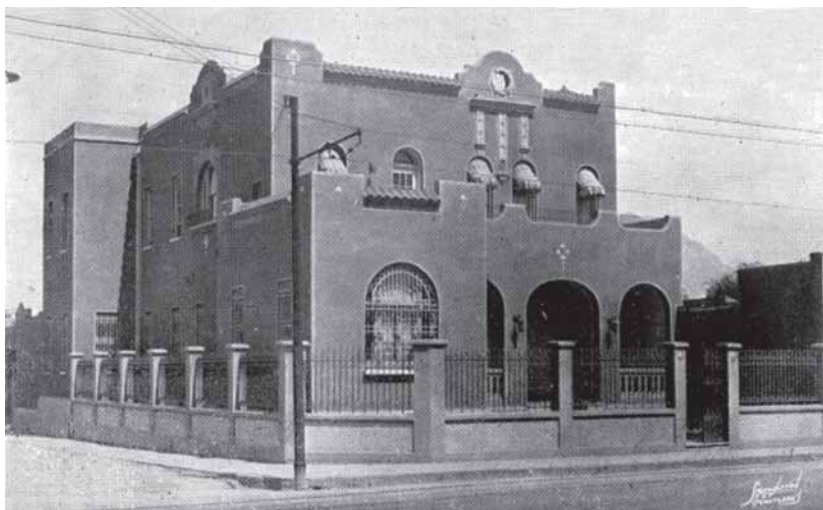
Fachada de la residencia del Dr. José G. Martínez proyectada por el Ing. Arq. José F. Muguera y construida por Brígido Oria con bloques de concreto.
